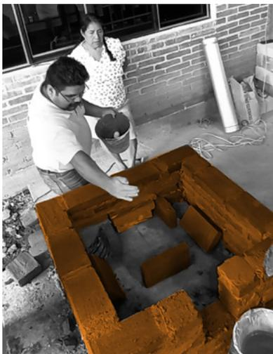
4. En donde se unen los cajones se coloca una hilada de ladrillos y se coloca la base metálica en donde se sentará el primer tubo de la chimenea.
