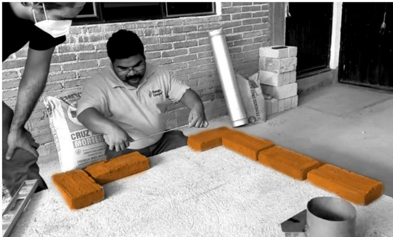
2. Después de tener el área en el que irá el comal colocamos cuatro hiladas de ladrillo en cuatropeados, es decir, que se ordenan de tal forma que no quede en línea recta, si no de manera zigzagueante. Este tipo de colocación da mayor fortaleza a la estructura y evita el agrietamiento. Para formar el contorno del cajón.
