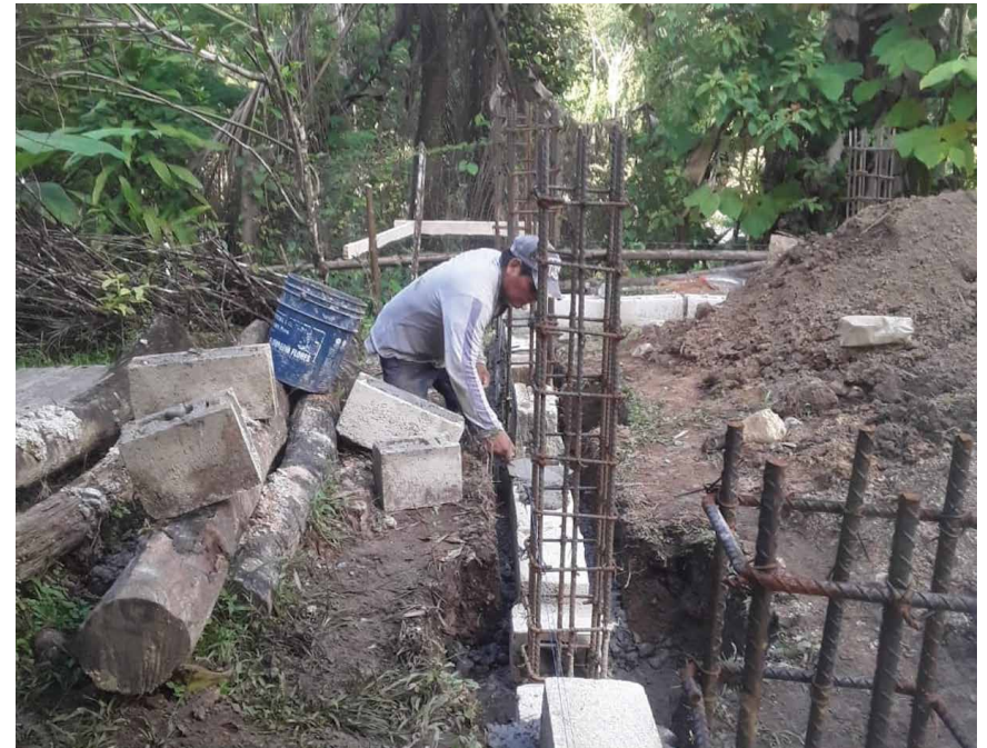
Caralampio colocando block para recibir la cadena. Fotografía: Equipo de Loma Bonita.
