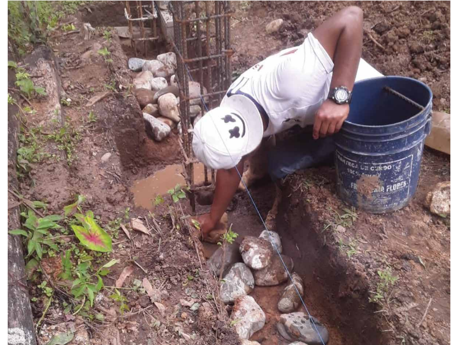
Neysler colocando la piedra para la cimentación. Fotografía: Equipo de Loma Bonita.
